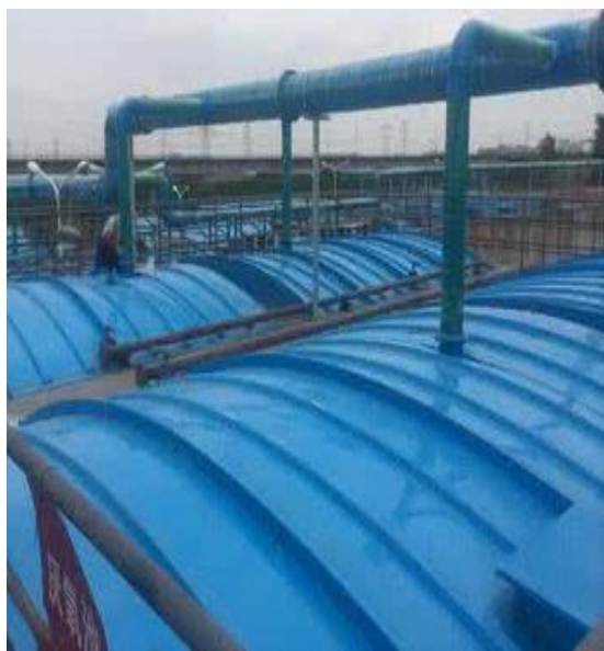
污水收集池加盖
