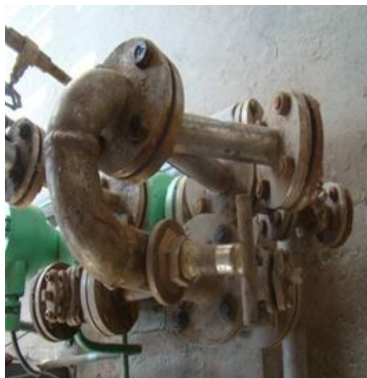
管道针形取样器
