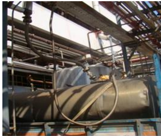
槽罐车进料排空平衡装
